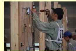
電気工事部門
