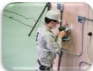
電気工事部門
